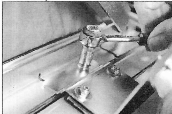
Abb.: Außenhalter herunterdrücken und festschrauben
