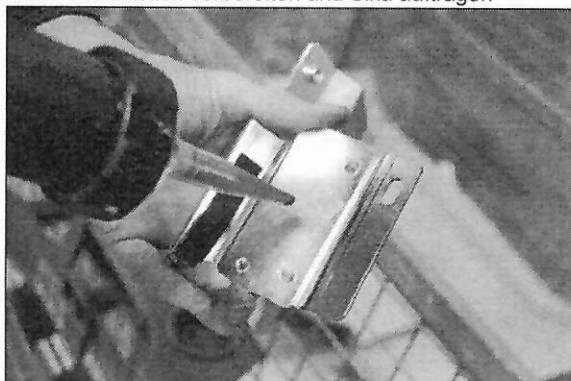
Abb.: Klebestellen vorbereiten und Sika auftragen
